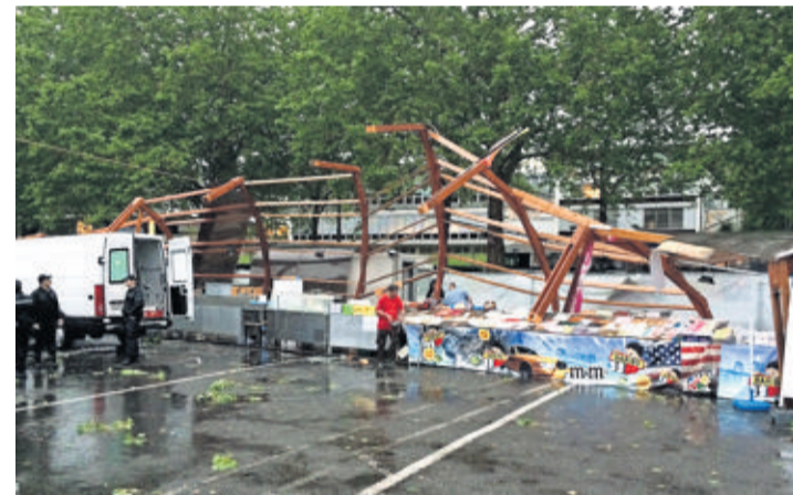
La fan zone de Bellerive a subi la tempête de plein fouet et a dû être évacuée par mesure de sécurité. POLICE DE LAUSANNE
